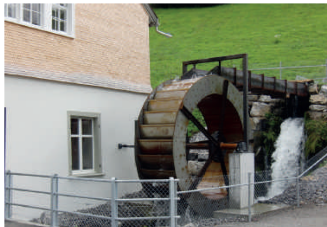
ansicht von der strassenseite
