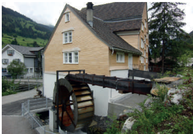
ansicht mit dem einlaufkanal
