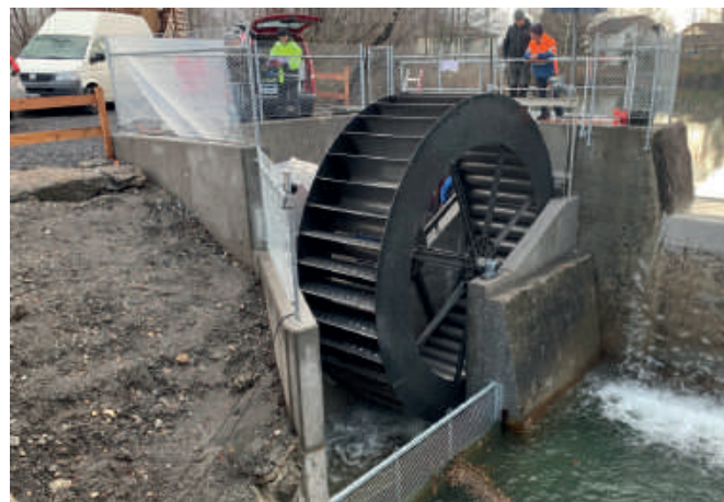
ansicht von der unterwasserseite
