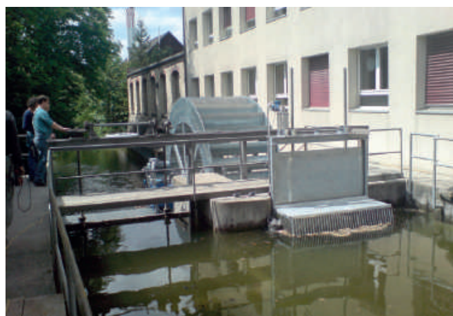
ansicht von oberkanalseite mit einlauf
